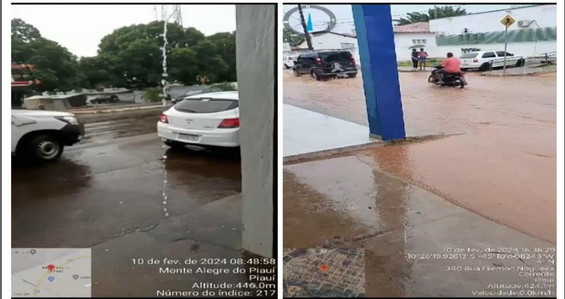
Fotos – Chuvas Intensas – Durante o período do evento, as chuvas intensas deixaram ruas alagadas e causaram interrupções para grandes blocos de clientes.
