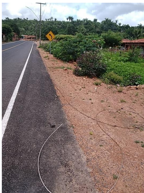
Foto – Cabo partido na estrada Local: Altos. Regional: Metropolitana. Data: 06/02/2023
