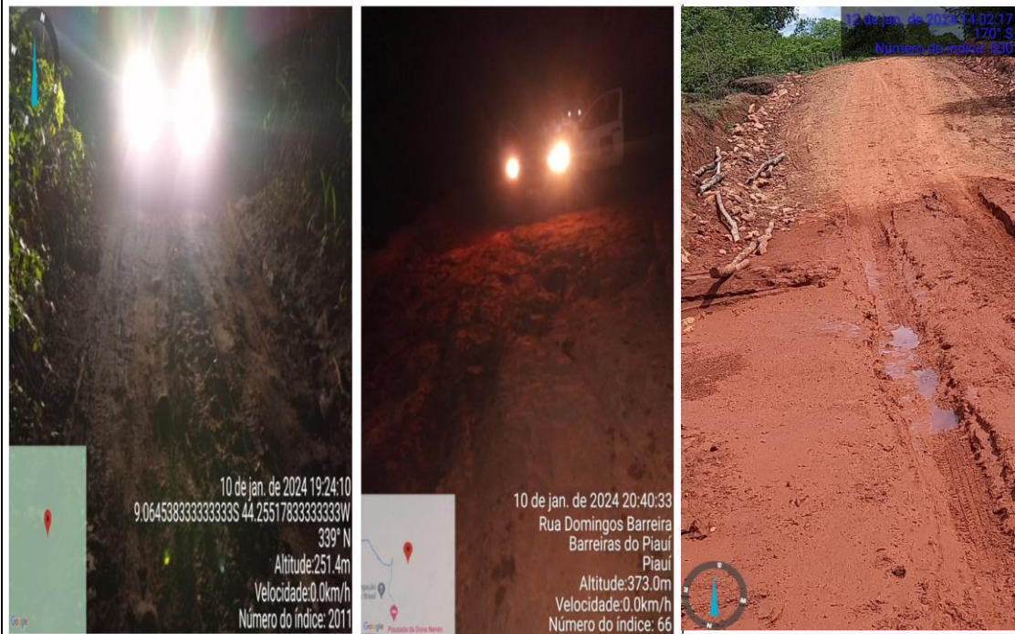
Fotos – Dificuldade de acesso – Devido as fortes chuvas, algumas áreas ficaram alagadas, áreas ficaram alagadas, o que dificultou a chegada das equipes ao local que dificultou a chegada das equipes ao local.
