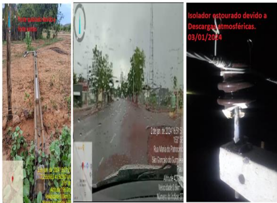
Fotos – Fortes chuvas, durante o período do evento as chuvas intensas e descargas atmosféricas dificultaram a atuação imediata das equipes.
