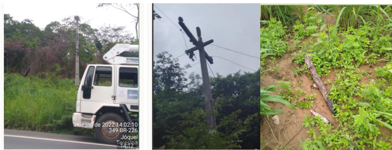
Figura 4 - Equipe pesada não conseguiu entrar em região alagada onde o cabo rompeu devido a ação da chuva e vento sobre a vegetação.
