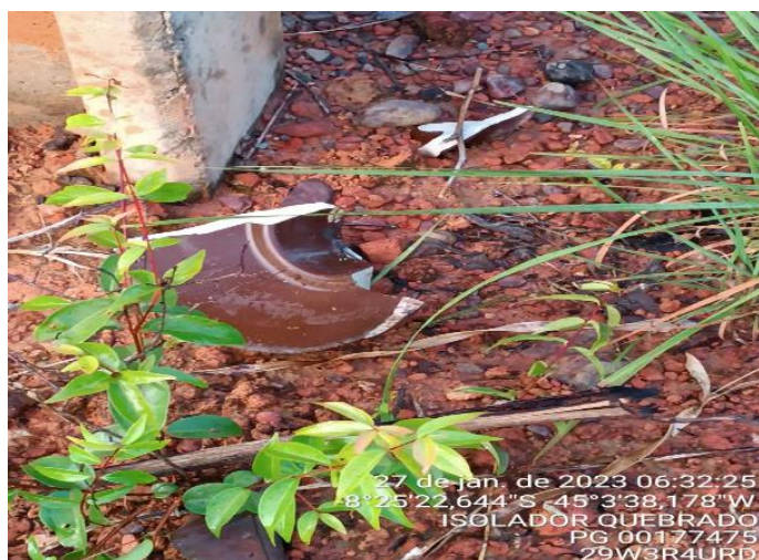
Foto – Água na via de passagem
