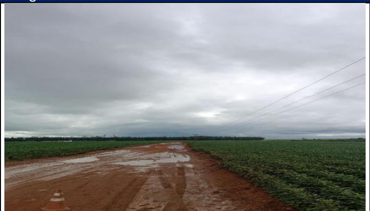
Foto – Área alagada
