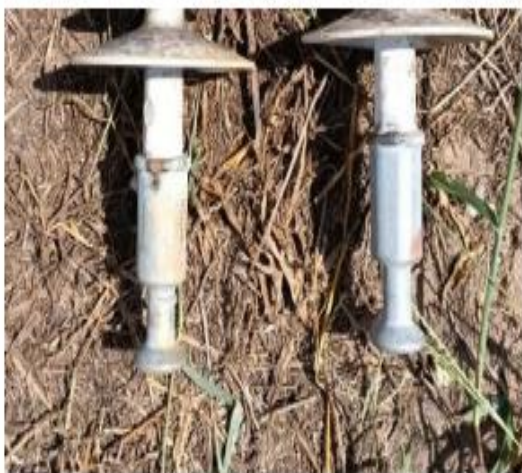
Foto – Detalhe do ponto do defeito. Regional: NORTE Ocorrência: 19791. Data: 03/05/2024.
