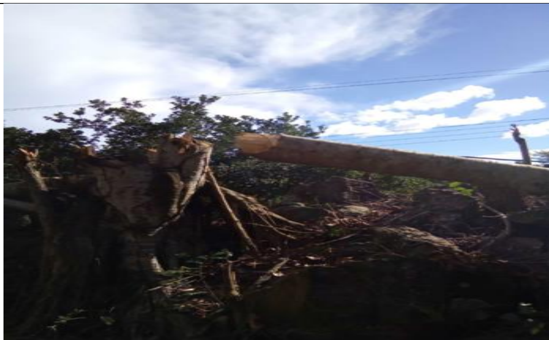
Foto – Ventania – Ventania causou a queda de árvore de grande porte sobre a rede, ocasionando rompimento de condutor e interrupção para grandes blocos de clientes.
