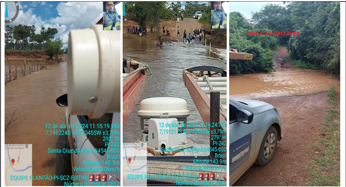
Foto – Dificuldade de Acesso – Alagamento na estrada, impossibilitou a chegada da equipe ao local de defeito. Município: Santa Cruz do Piauí Regional: Picos Data: 12/04/2024.
