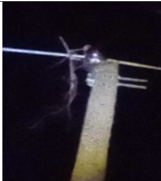
Foto – Ventania – Fortes ventos arremecaram galho sobre a rede, ocasionando curto e interrupção para grandes blocos de clientes.
