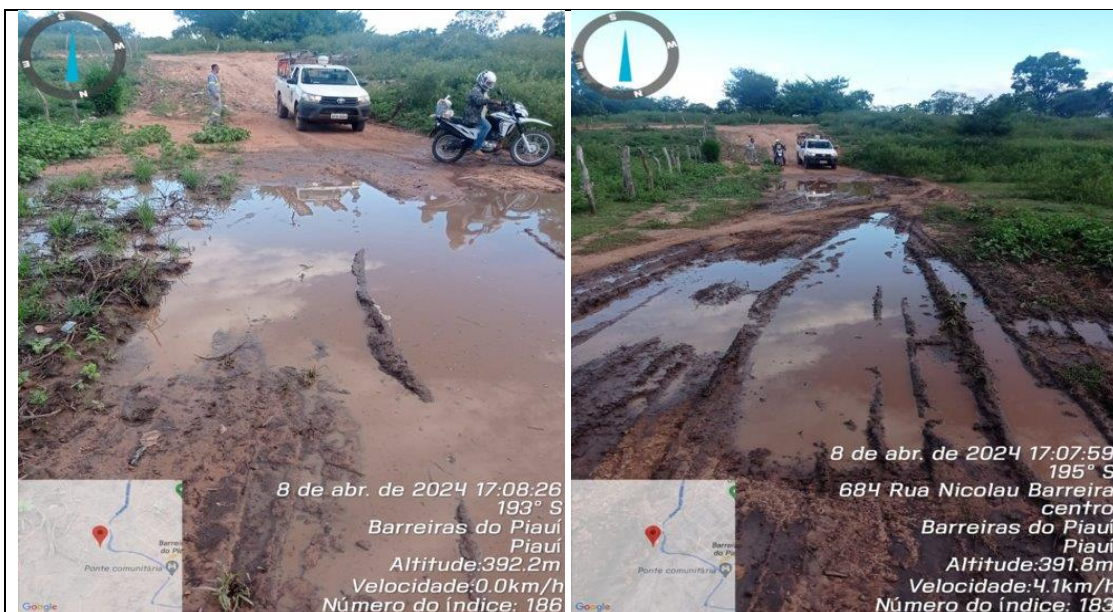
Foto – Dificuldade de acesso – Devido ao alto volume de chuvas, algumas estradas de barro criaram regiões de atoleiros, dificultando o acesso imediato das equipes aos locais de defeito. Regional: Floriano Município: Barreiras do Piauí Data: 08/04/2024
