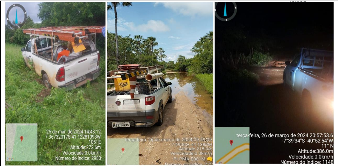
Foto – Dificuldade de acesso por alagamento, devido alto volume de chuvas. Regional: Sul Data: 26/03/2024
