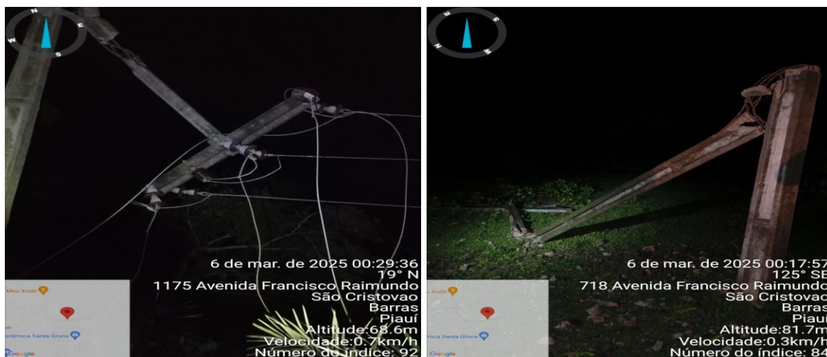
Foto – Ventania – Fortes ventos ocasionaram a quebra de galhos de árvore que, caíram sobre a rede ocasionando quebra de poste
