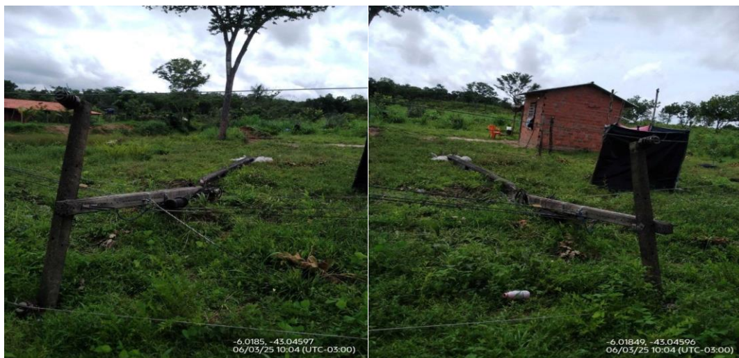
Foto – Forte tempestade e ventania causaram tombamento de poste. Regional: Metropolitana Município: Palmeirais Data: 06/03/2025 Ocorrência: 41989-03-2025
