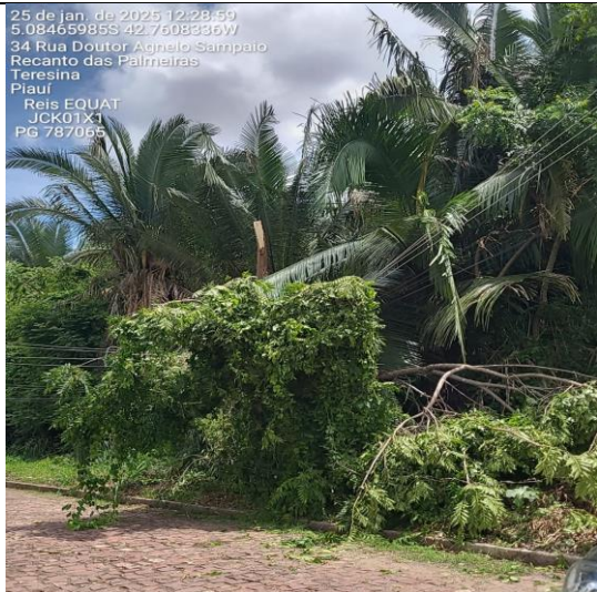
Foto – Ventania – Fortes ventos ocasionaram a quebra de galhos de árvore que, caíram sobre a rede ocasionando curto circuito e interrupção. Regional: Metropolitana Município: Teresina Ocorrência: 156639-1-2025 Data: 25/01/2025.
