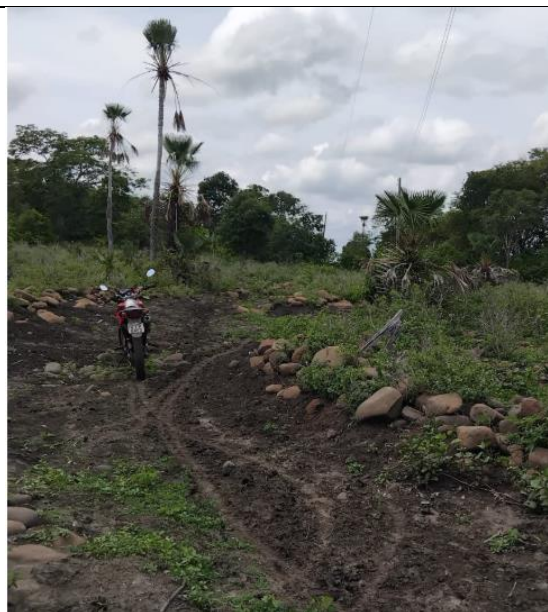
Foto – Devido as fortes chuvas e ventania houve queda de galhos de árvore sobre a rede e consequentemente desarme da chave. Município: Esperantina Regional: Norte Data: 25/01/2025.
