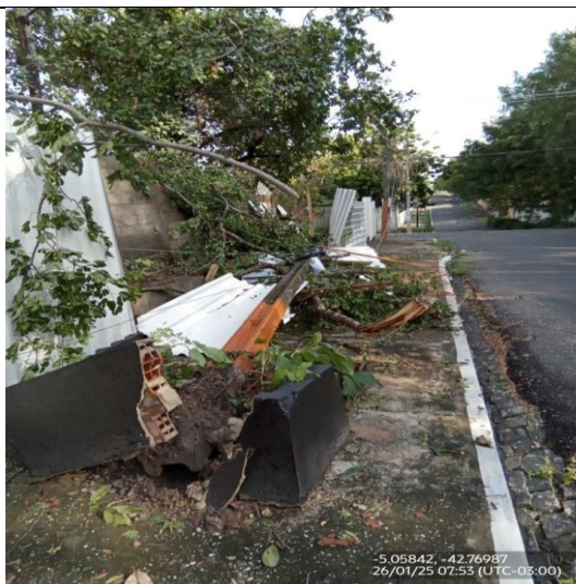
Foto – TEMPESTADE com ventos intensos derrubaram árvores e postes, obstruindo o circuito e dificultando a restauração
