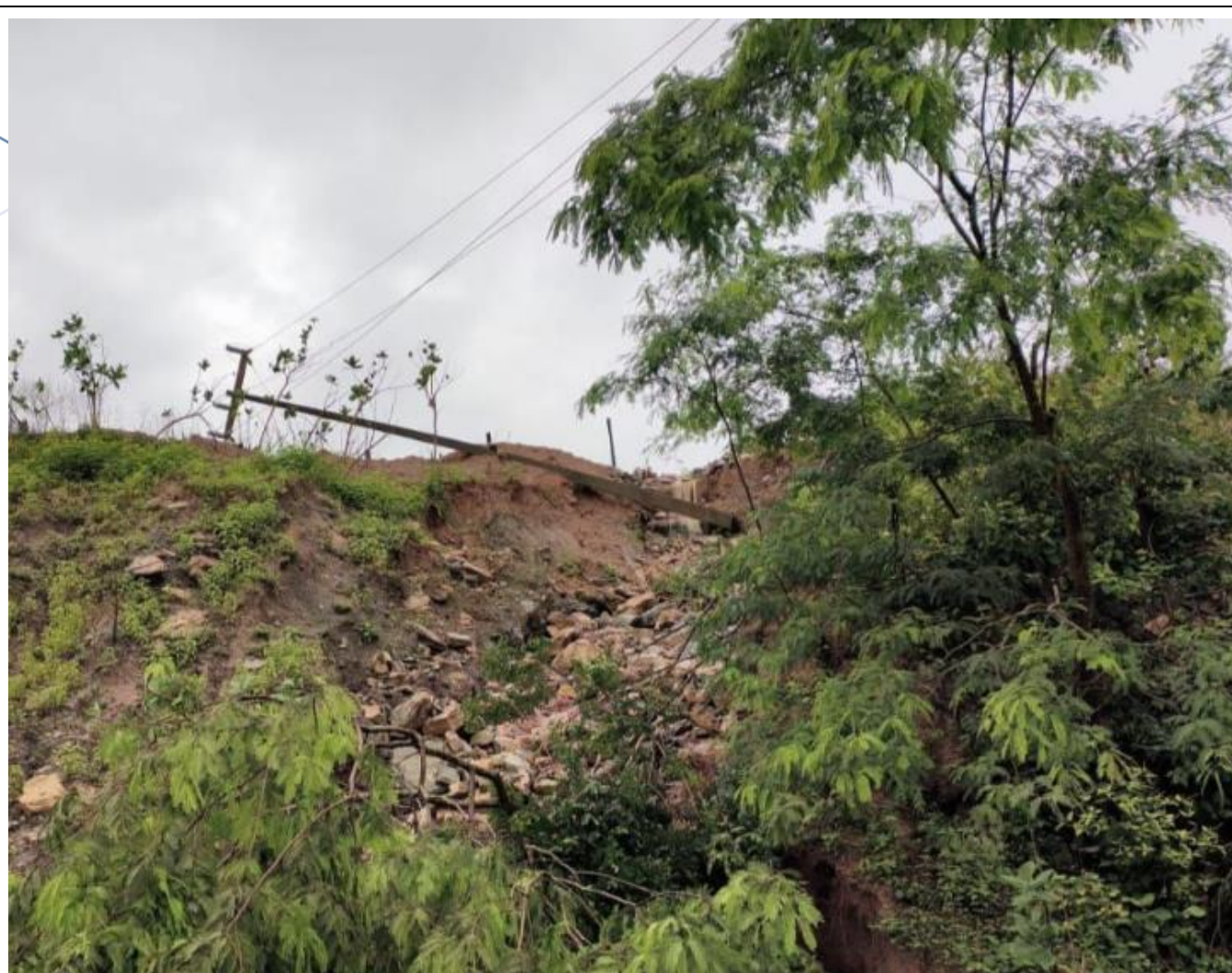
Fotos – Atendimento de ocorrência sem acesso. Local: Picos. Regional: Sul. Data: 08/01/2025. Equipe: Emergencial
