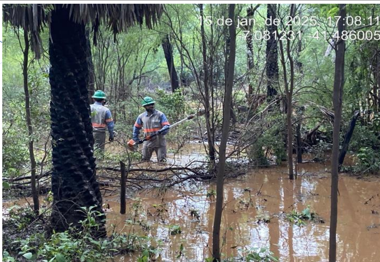
Fotos – Atendimento a uma ocorrência, local de difícil acesso. Local: Picos. Regional: Sul. Data: 15/01/2025. Equipe: Fiscal + emergencial
