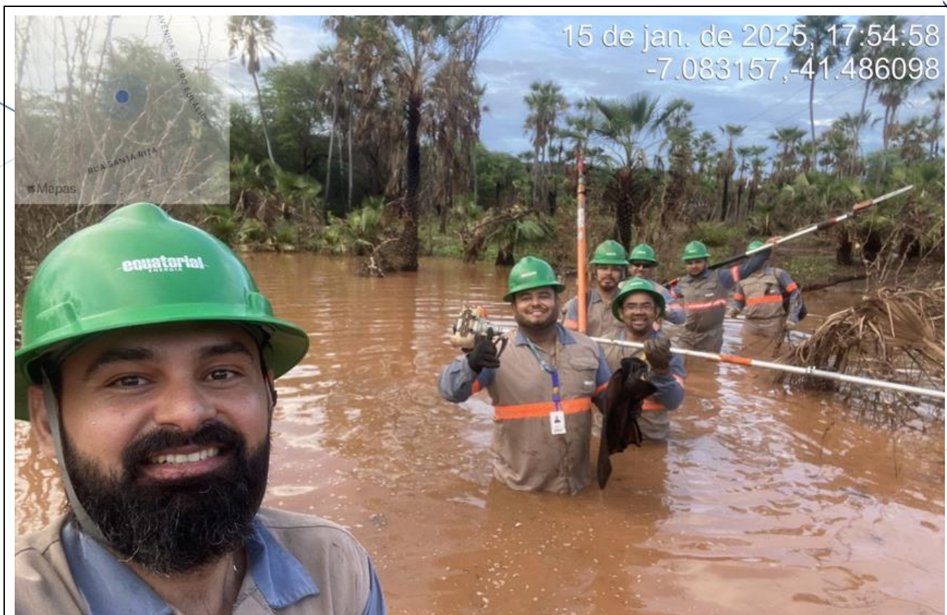
Fotos – Inspeccionando defeito no circuito, local de difícil acesso. Local: Picos. Regional: Sul. Data: 15/01/2025. Equipe: Fiscal + 02 equipes do emergencial.
