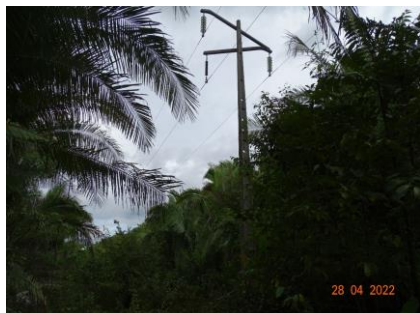
Foto 5 – Isolador Substituído
