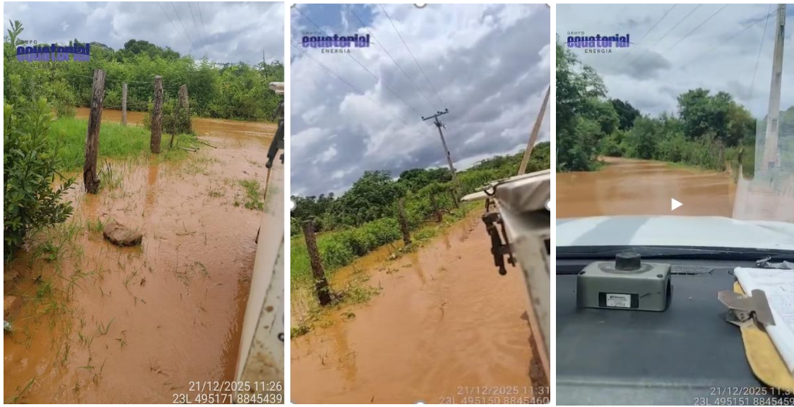
Foto – Forte chuva ocorrida no dia 21/12/2025 ocasionando desarme do disjuntor 19S1 da Subestação Corrente e na pesquisa de defeito e recomposição houve dificuldades devido alagamento e difícil acesso Regional: Floriano Município: Corrente Data: 21/12/2025 Ocorrência: 169517-12-2025
