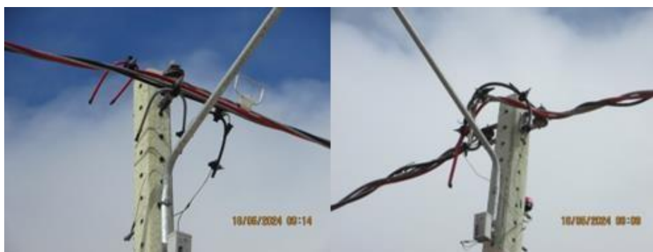
Figura 2 – Rede de distribuição multiplexada - BT.
