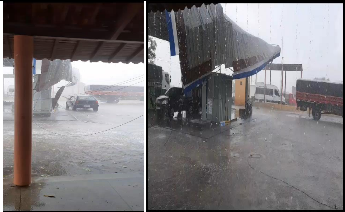
Fotos – Ventania – Durante a chuva uma ventania danificou uma cobertura que atingiu a rede, ocasionando interrupção.
