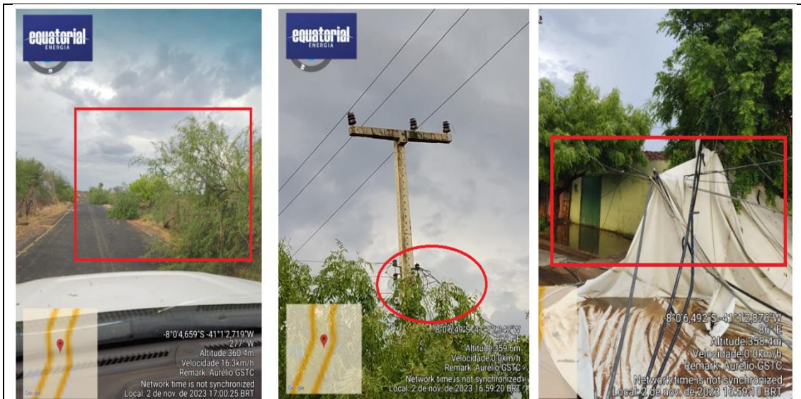
Fotos – Ventania – Durante a chuva uma ventania causou a queda de árvores e lançou objetos sobre a rede.
