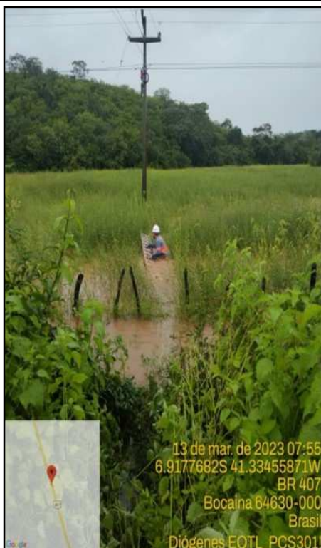
Foto 1 – Equipe com impossibilidade de acesso ao ponto de defeito.
