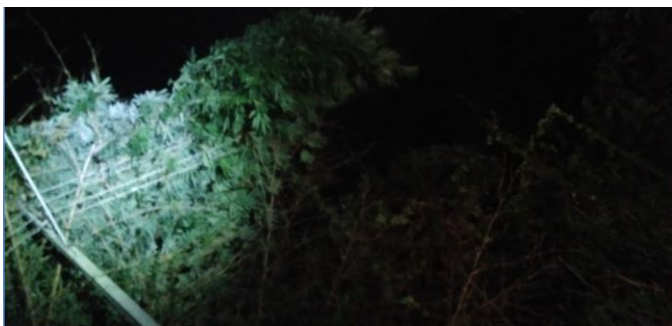
Foto – Poste quebrado Regional: Norte. Data: 02/02/2023
