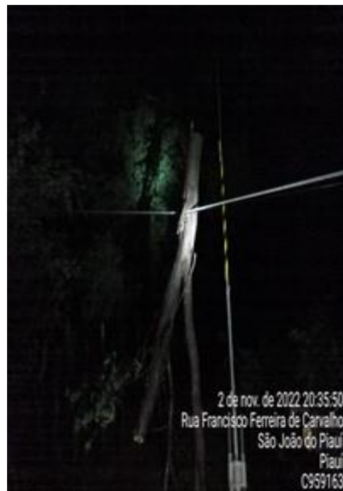
Foto – Área de Difícil Acesso
