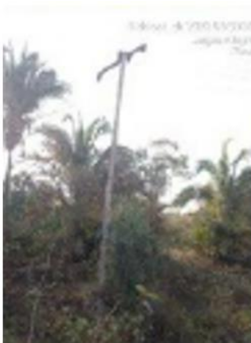
Foto – Fortes Ventos: Poste de MT derrubado pela Vegetação e Topo de Poste de MT quebrado
