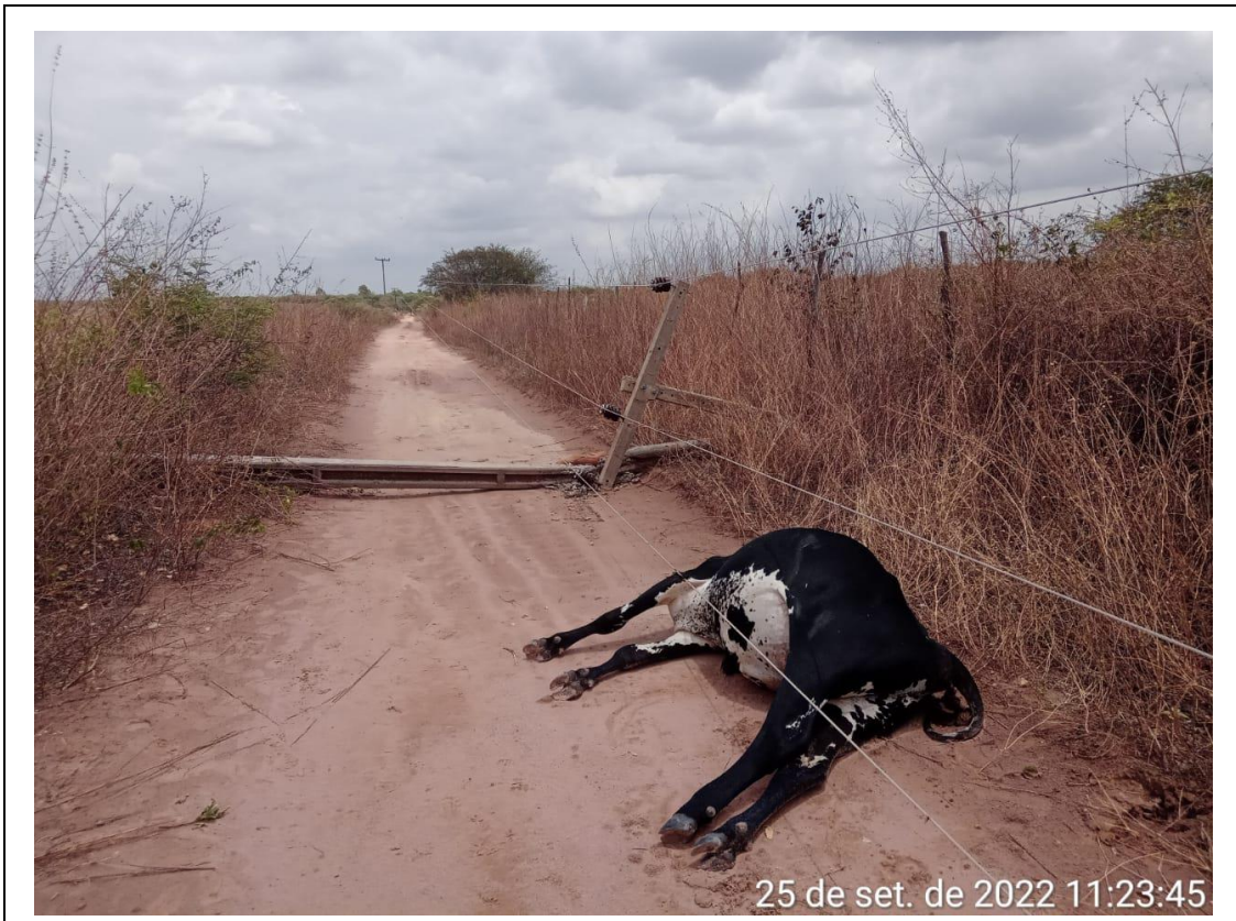
Foto – Poste de MT derrubado pelos fortes ventos – Canto do Buriti
