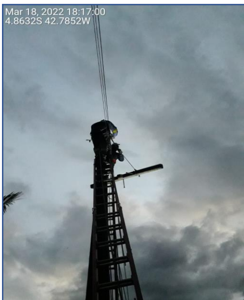
Foto – Trabalhos realizados para a normalização do sistema.
