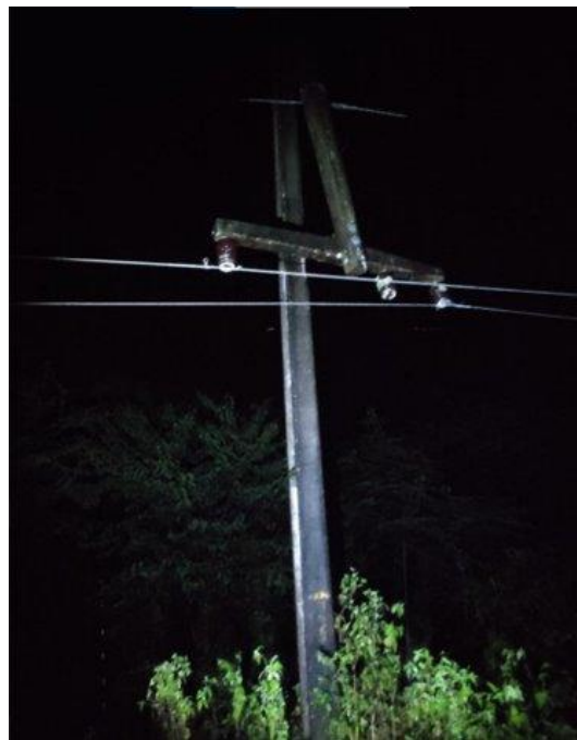
Foto – poste danificado causado por rompimento de cabo a partir de arvore na rede em decorrências as fortes chuvas.
