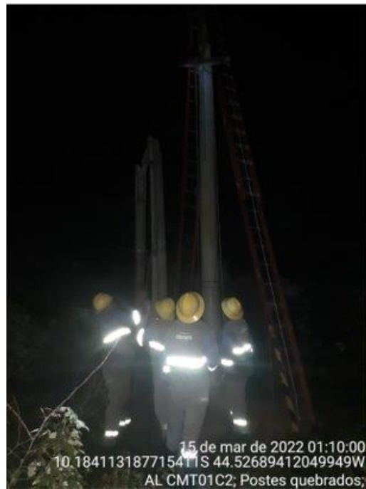
Foto – Poste danificado.
