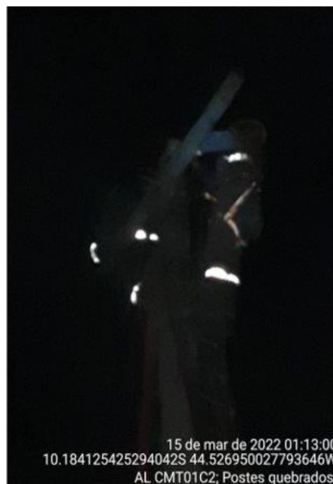
Foto – Substituição de cruzeta danificada
