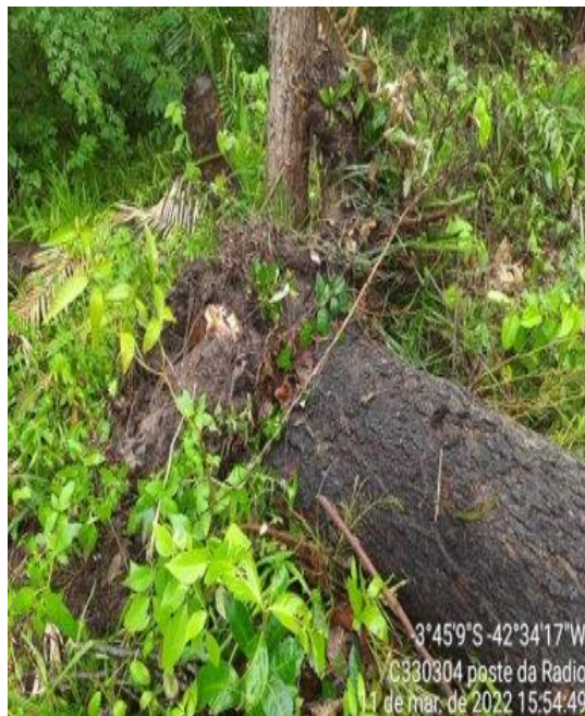
Foto – Cabo partido causada por arvore na rede em decorrências as fortes chuvas.
