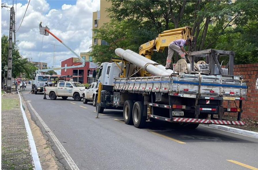
Figura 13 - Mobilização das equipes para substituir postes afetadas pelos eventos em Teresina.
