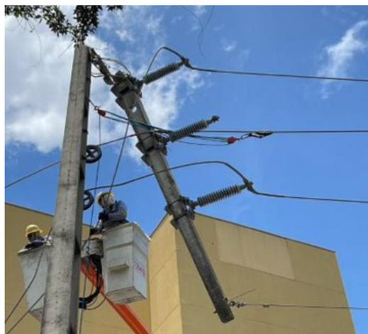
**Figura 8 – Equipe pesada inicia a recuperação da rede MT em poste quebrado.**
